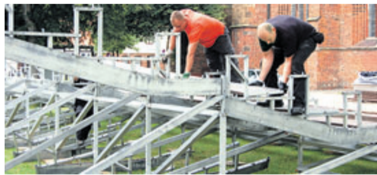
Auf dem Festspielgelände am Dom wird fleißig gewerkelt. Die überdachten mobilen Tribünen sollen heute komplett stehen. FOTO: SIEPMANN
